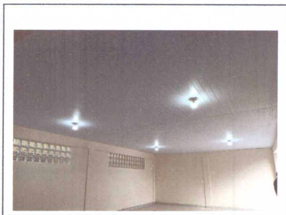
INSTALAÇÃO PONTOS DE LUZ
