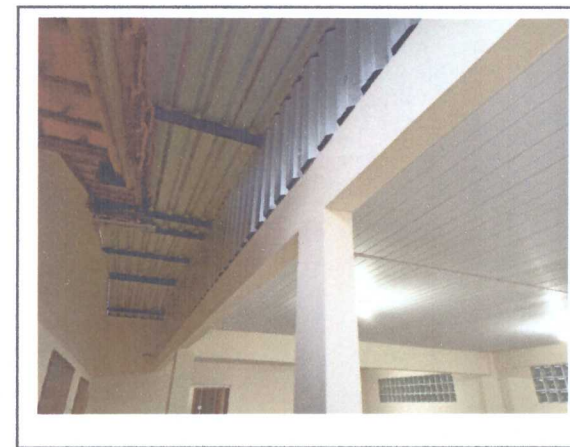
FORRO DE PVC E FECHAMENTO LATERAL DO TELHADO
