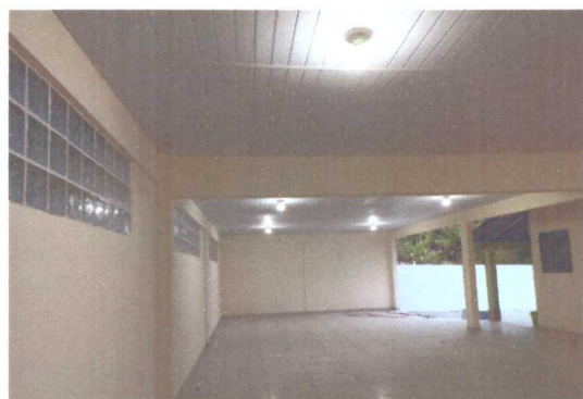
FORRO PVC E ILUMINAÇÃO
