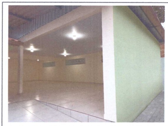
ASS. PISO, FORRO PVC, ILUMINAÇÃO E FECHAMENTO LATERAL TELHADO
