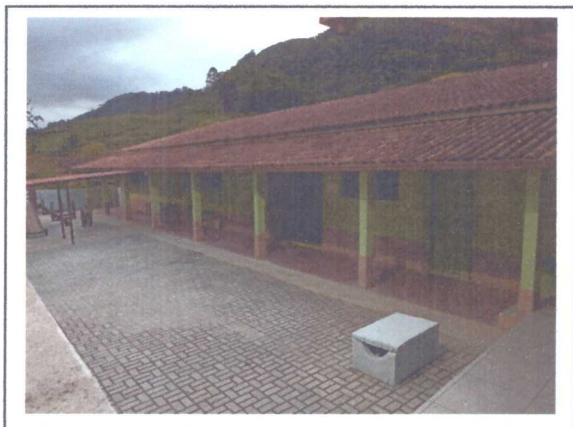
PINTURA GERAL, PAVIMENTAÇÃO E REVESTIMENTO DA FACHADA
