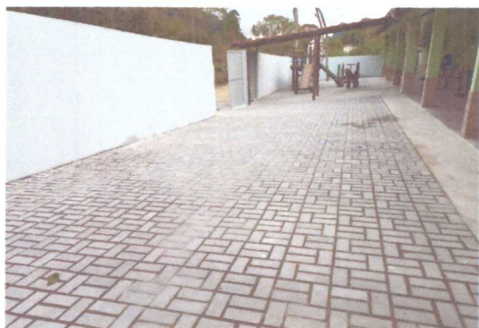
PAVIMENTAÇÃO COM INTERTRAVADO
