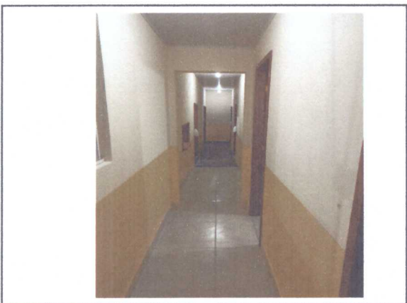
PINTURA DO CORREDOR
