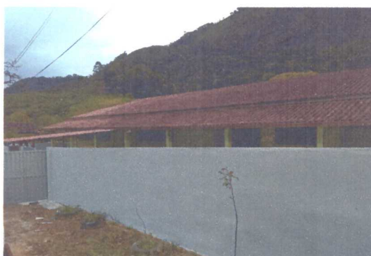
PINTURA DO MURO FRONTAL
